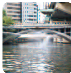
東橫堀川水門
