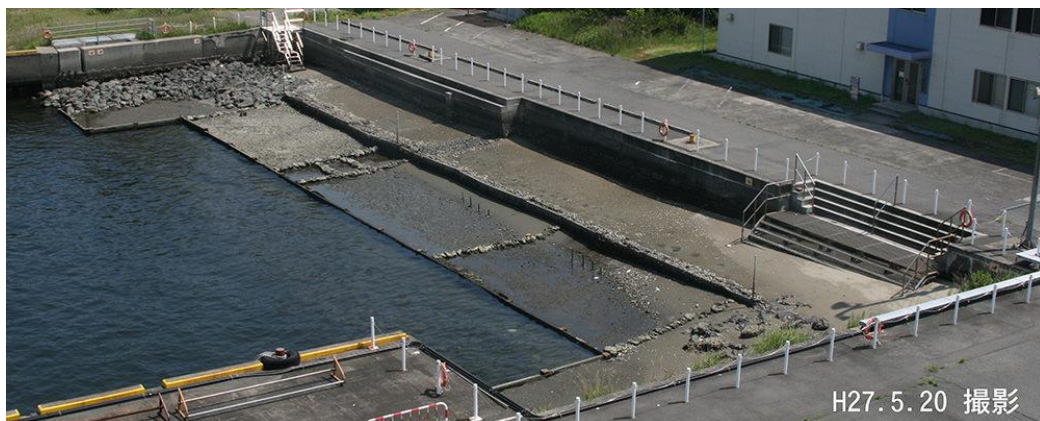
【人工干潟を用いた生物共生型護岸『潮彩の渚』（出典：国土交通省関東地方整備局 横浜港湾空港技術調査事務所 HP）】
