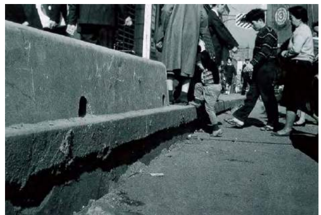
3-11 地盤沈下で陥没した道路
